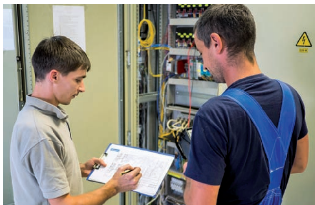
Alexandr Svet (vľavo), vedúci zmeny a špecialista automatizácie, prispel aj s ďalšími kolegami k vybudovaniu moderného systému riadenia cukrovary v Drochii. V pozadí rozvádzač s decentralizovaným systémom riadenia Yokogawa CentumVP ver R6.
